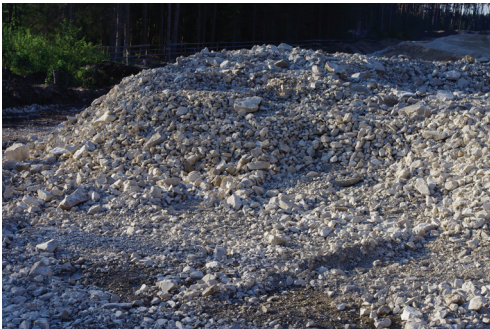
Abb. 9: Grobschotter, der unter der neuen Straßentrasse den Wasserdurchfluss sicherstellen soll. Nach Ansicht von Tiefbau-Fachleuten handelt es sich um eine heute übliche Maßnahme.
