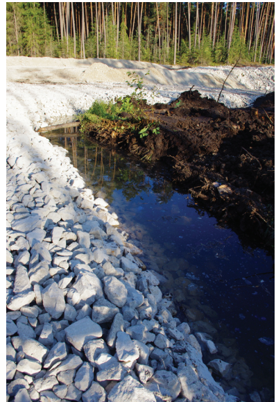
Abb. 9: Grobschotter, der unter der neuen Straßentrasse den Wasserdurchfluss sicherstellen soll. Nach Ansicht von Tiefbau-Fachleuten handelt es sich um eine heute übliche Maßnahme.
