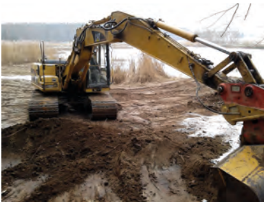
Abb. 2: Mittels Kettenbagger wurde das Aushubmaterial als Flachwasserzone gestaltet
